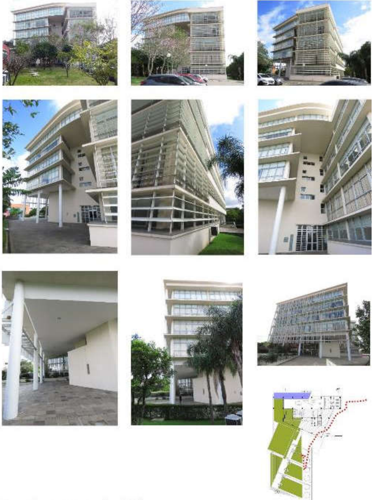
Figura 92 - Mosaico 02 de fotos do edifício da Faculdades FAPA – Prédio 04 – Administração central (2007), Porto Alegre, Brasil.
