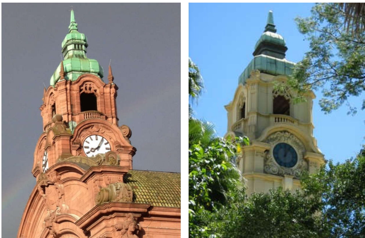
Figura 32 – Comparação das torres da estação de Wiesbaden e dos Correios e Telégrafos de Porto Alegre.
