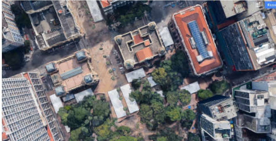
Figura 27 - Vista aérea conjunto edificado da Praça da Alfândega, com destaque para os estudos de caso Correios e Telégrafos e Delegacia Fiscal e Banco do Comércio.
