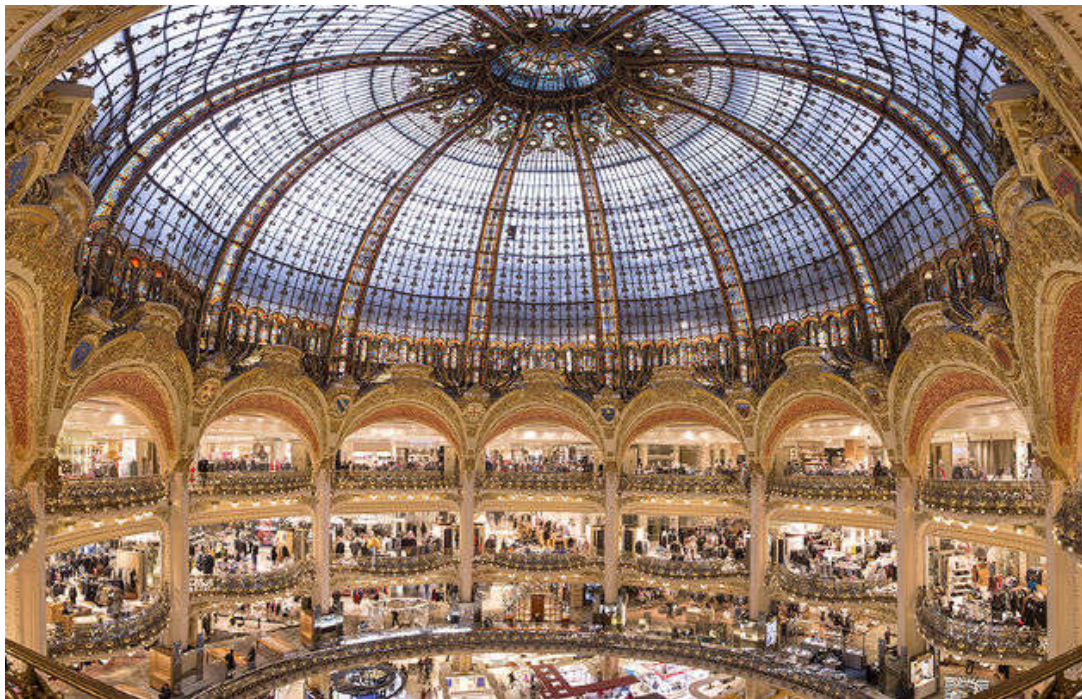
Figura 19 - Vista interna do saguão sob cúpula de vitral da Galeria Lafayette (1912), Paris, França.
