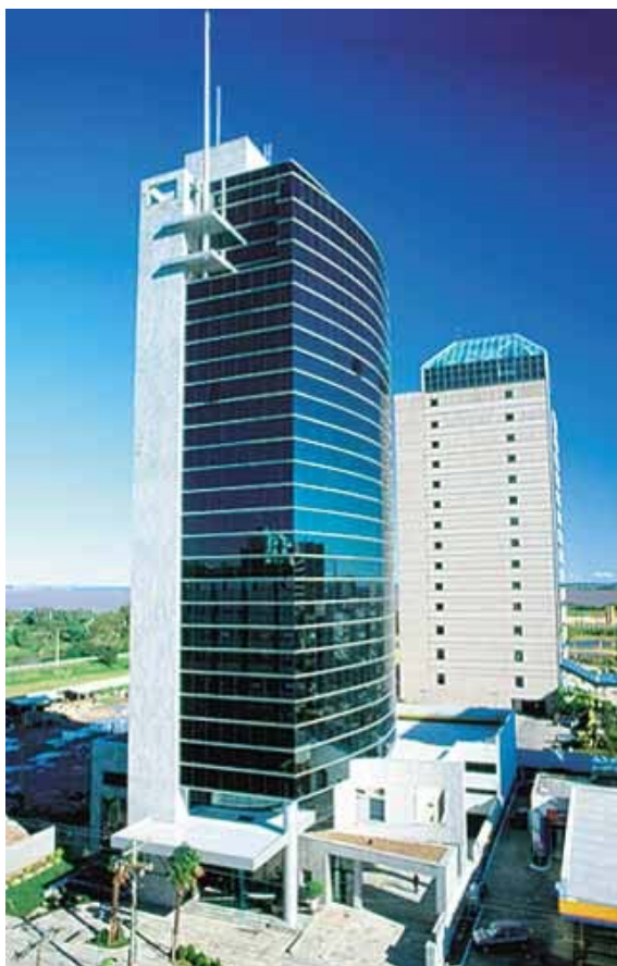
Figura 10 - A localização do prédio tira partido da paisagem e da crescente valorização da região. A transparência das fachadas aproveita a vista privilegiada.
