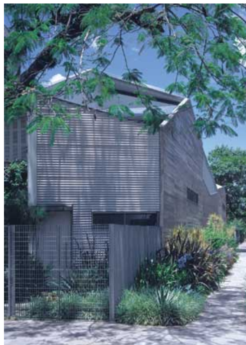
Figura 09 - Fachada principal na qual se destaca a tipologia compacta, baixa e junto às divisas. A pureza geométrica da volumetria expressa-se através dos elementos compositivos típicos da linguagem modernista: planos lisos, ângulos retos, adições e subtrações de volumes. Os materiais dão à construção um aspecto bastante atual e inovador.
