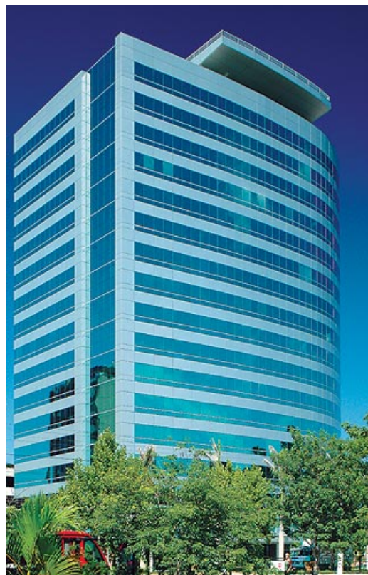
Figura 31 (ao lado) - A fachada frontal configura uma lâmina curva e demarca a esquina. O térreo com pé-direito duplo e marquise suspensa por cabos conferem monumentalidade ao acesso. No alto do prédio a plataforma destinada ao heliponto. A composição de fachada, com faixas horizontais definidas por materiais nobres e tecnológicos conferem um aspecto limpo e requintado e contemporâneo.
