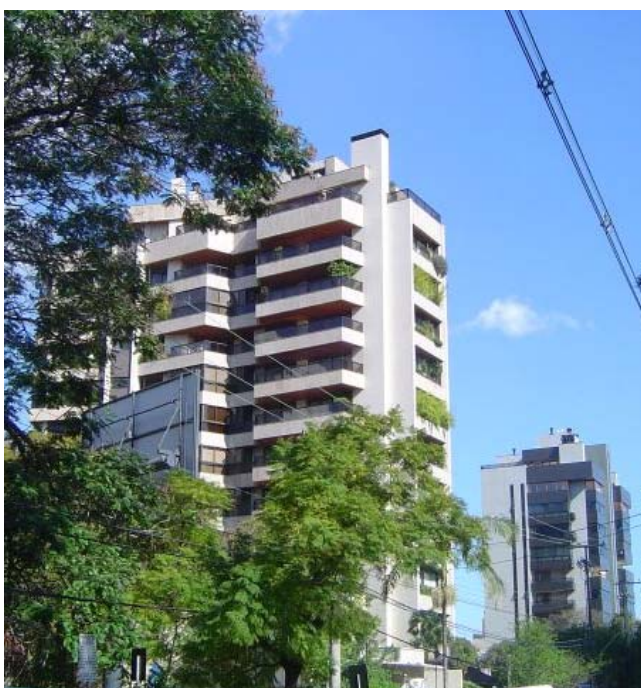
Figura 7 - Foto do Edifício Residencial Castelo de Heidelberg e entorno. A verticalidade da volumetria se destaca entre casas baixas ainda remanescentes, porém adota o padrão tipológico das novas construções, de acordo com a legislação então vigente e ainda acentuada pelo novo plano diretor.
