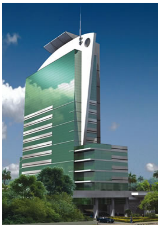
Figura 33 (ao lado) - A volumetria da base é composta volumes menores na parte frontal e um maior, para os estacionamentos, na parte posterior. Esta fragmentação confere destaque ao prisma vertical seccionado pela grande lâmina branca e coroado pela plataforma destinada ao heliponto. A composição de fachada define-se através da alternância entre faixas horizontais e panos de vidro refletivo, materiais nobres e tecnológicos que conferem um aspecto limpo e realçam a verticalidade. Note-se a resumida adoção de brises horizontais no volume menor (mais decorativos do que funcionais, haja vista a desproteção do prisma vertical). O térreo é marcado pelo pé-direito duplo que confere monumentalidade ao acesso.
