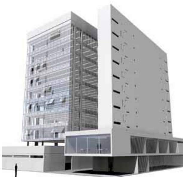
Figura 21 - A perspectiva a partir do noroeste apresenta o prisma que funciona como proteção solar. A fachada leste (oposta) é protegida por brises. Materiais contemporâneos dão um aspecto atual a uma linguagem característica da arquitetura modernista. Observe-se a permeabilidade do pavimento térreo estabelecendo a relação com o espaço aberto e unindo os acessos. A influência da arquitetura modernista vai além da explícita relação forma-função. Note-se também a composição de volumes puros, pilotis de transição entre a base e o corpo, assimetrias, planos e linhas trabalhados pela relação de cheios e vazios.
