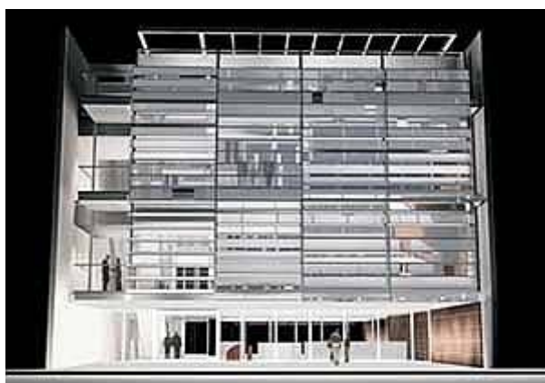
Figura 18 - A fachada principal (norte) é protegida por brises. Materiais contemporâneos dão um aspecto atual à linguagem característica da arquitetura modernista. Observe-se ainda a permeabilidade do pavimento térreo unindo através do prédio as duas ruas.
