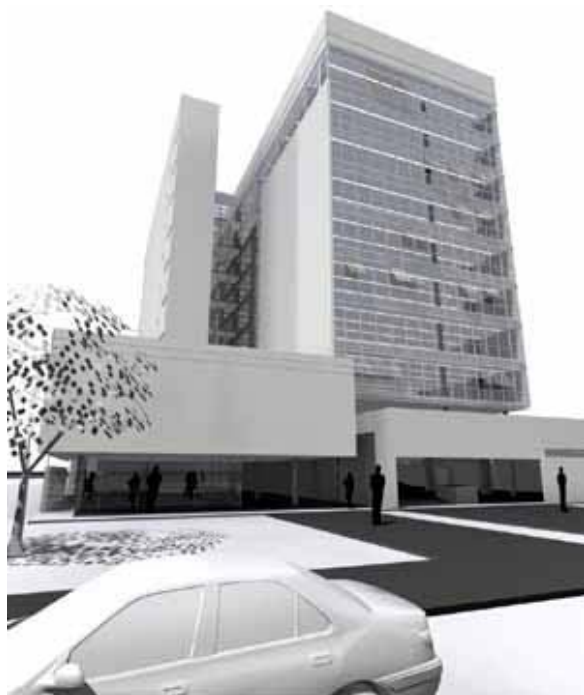
Figura 20 - A perspectiva a partir do sudoeste apresenta a composição volumétrica pela qual são definidos vários prismas separados segundo as funções que neles ocorrem. No corpo as circulações verticais (volume opaco) e escritórios (volume em vidro) articulados pelas passarelas das circulações horizontais. Na base estão as áreas de acesso ao público, apoios e estacionamentos. Evidencia-se assim a relação forma-função, um dos princípios da arquitetura modernista.
