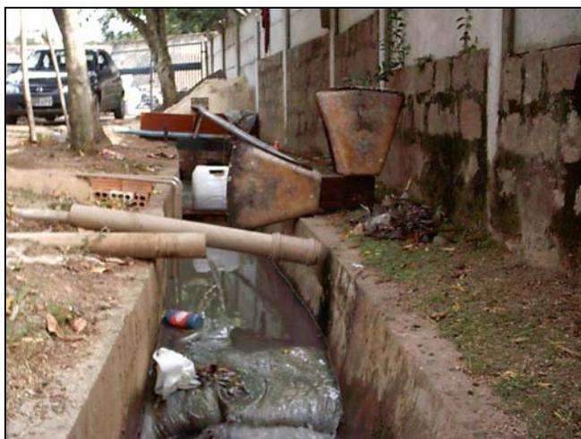
Figura 5.14 – Barragem para captação do esgoto
