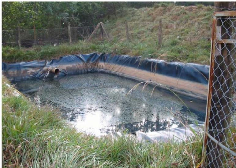
Figura 4.13- Tanque de lixiviado no pátio de compostagem
