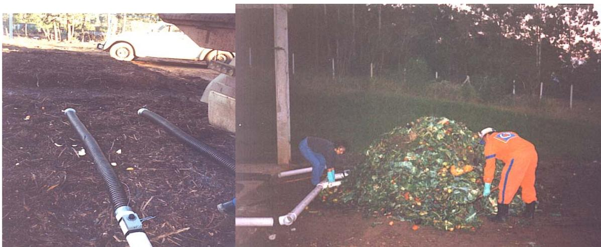
Figura 4.21- Montagem da leira estática aerada mecanicamente
