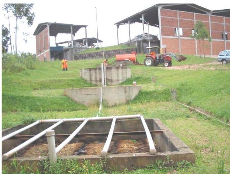
Figura 4.16-Sistema de abastecimento do lixiviado
