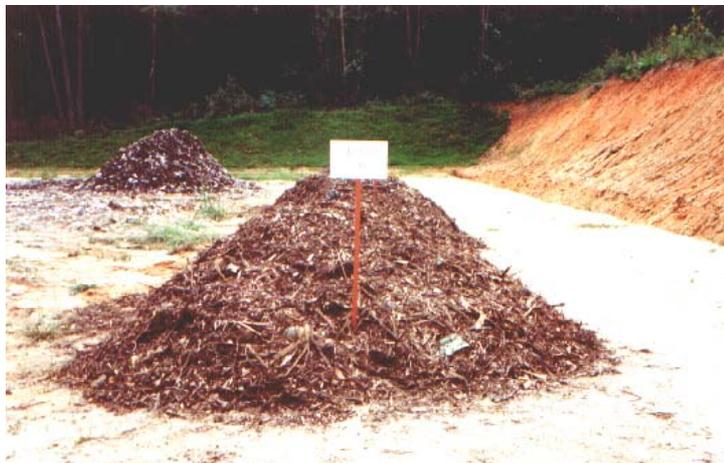
Figura 4.18- Montagem das leiras de compostagem tipo “windrow”
