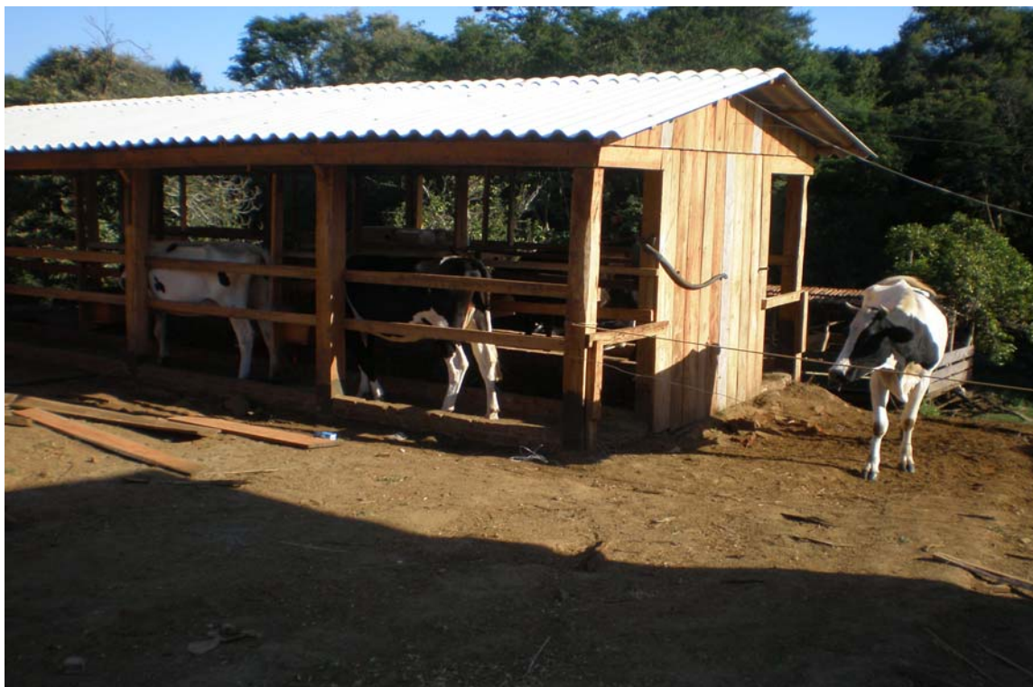
Estrebaria construída com recursos do Pronaf Investimento – Sete de Setembro/RS
