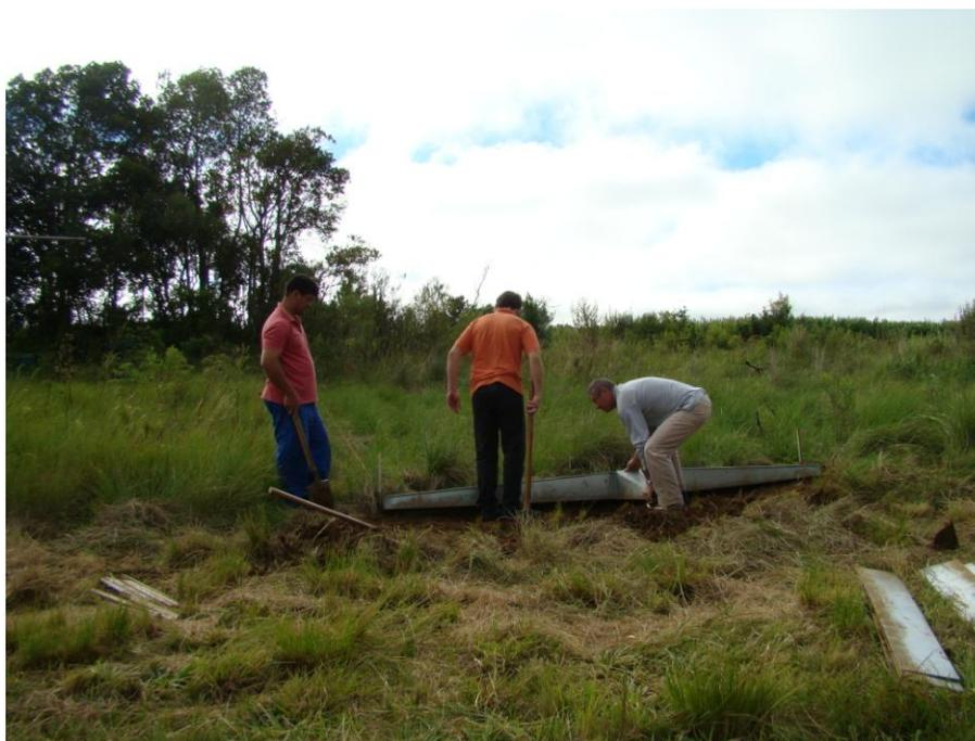
Figura 5: acertar o coletor quanto aos desvios mais grosseiros de solo. Utiliza-se solo que deve ser compactado, nunca pedras ou materiais orgânicos perecíveis, principalmente em trabalhos de longo prazo.
