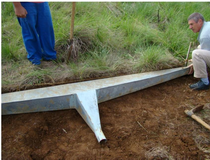
Figura 6: Ajuste fino no sentido lateral.
