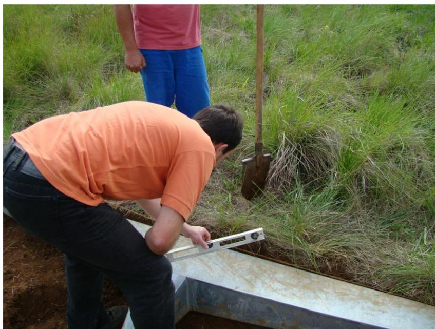
Figura 6: Utilizar o nível de pedreiro para nivelar e centralizar o coletor.
