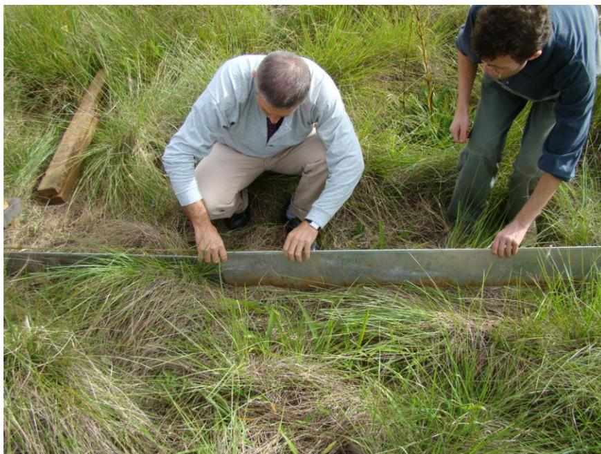
Figura 9: Detalhe do alinhamento entre as estacas e a sobreposição com a chapa anterior.
