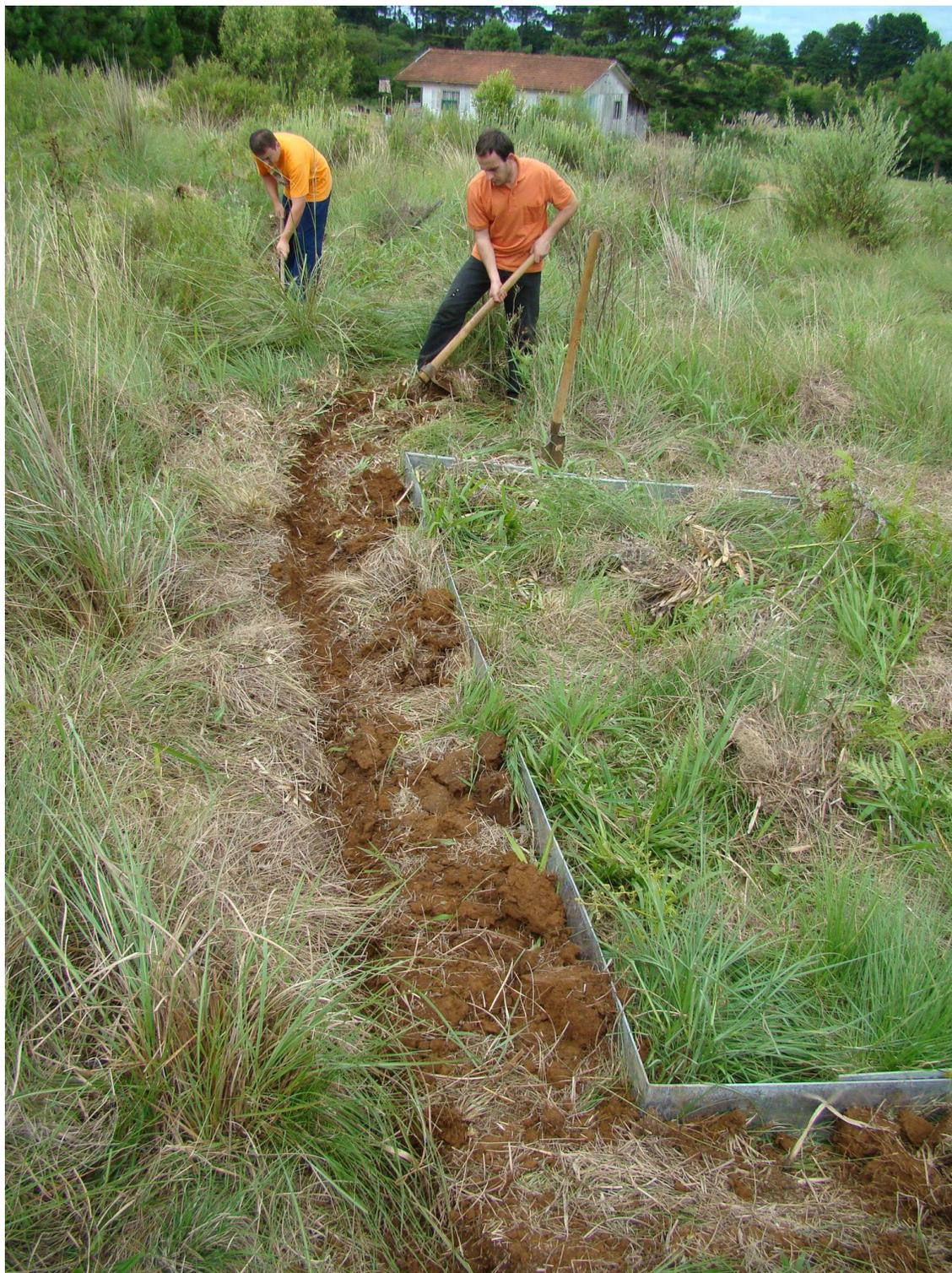
Figura 14: Valetamento, limpeza e achego de terra junto às paredes.
