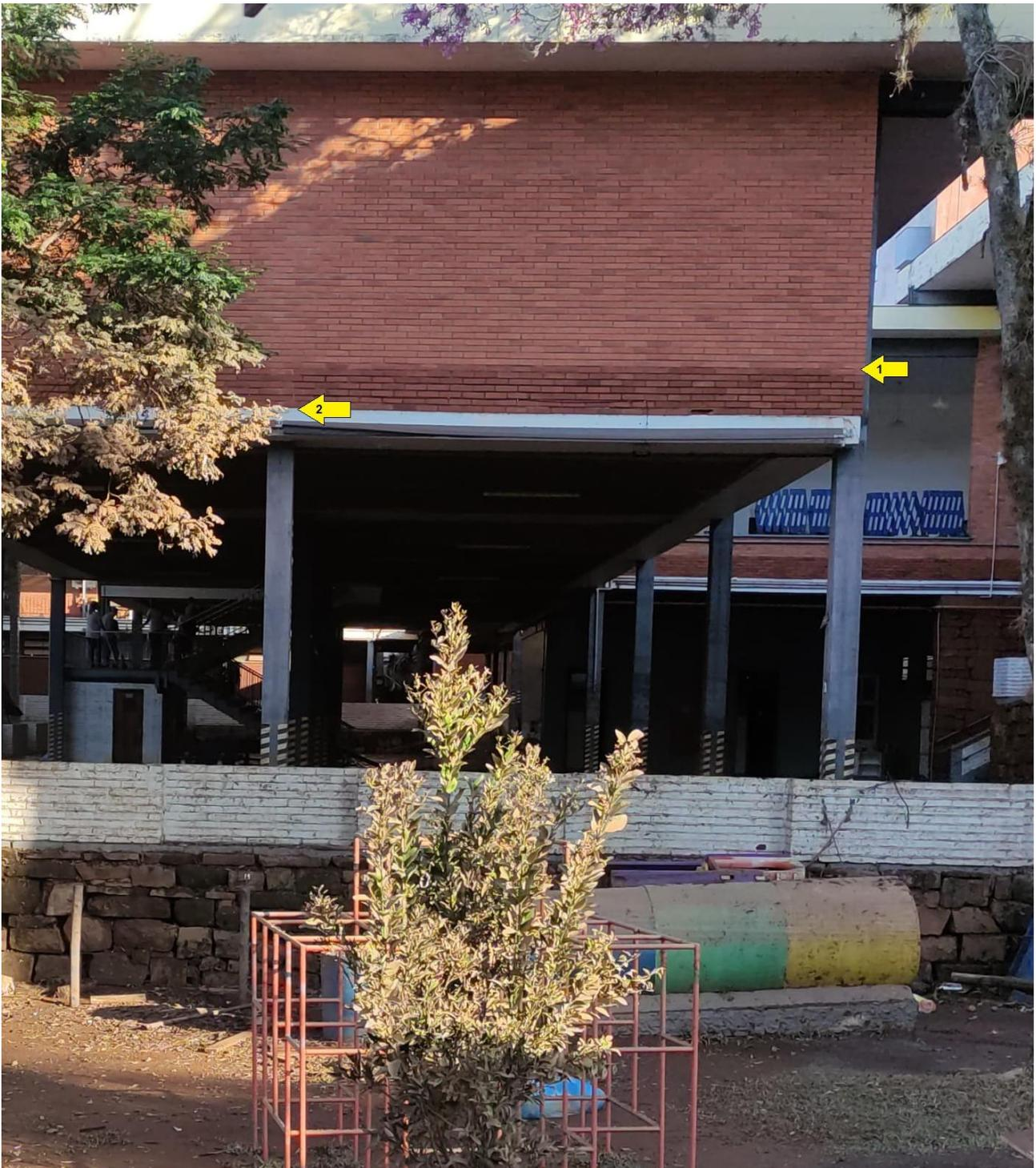
**Figura 6:** Vista lateral do pilar e do prédio do CEAT onde estão as marcas das inundações históricas, visto a partir da rua Carlos Von Koseritz, destacando a mancha de umidade resultante da inundação de 5 de setembro de 2023 (Seta 1), localizada 51 cm acima do limite superior da viga branca, que representa o local em que está marcado nível máximo da inundação de 05 de maio de 1941 (seta 2).
