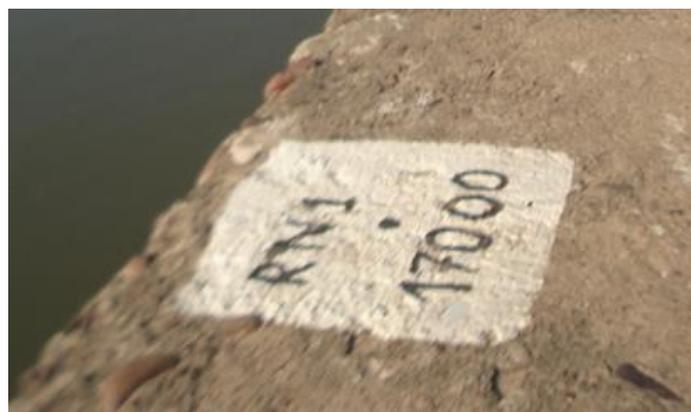
**Figura 10:** Cota arbitrária marcada sobre o cais do Porto Fluvial de Estrela (marco RN1) para apoiar as medições das réguas utilizadas para o monitoramento do nível do rio Taquari.
